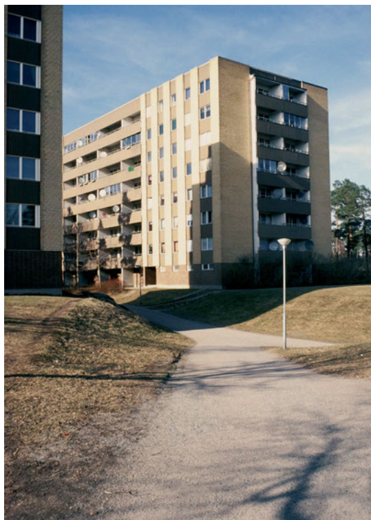
FIGUR 3: Inflyttningen i allmännyttiga Uppsalabems Norra Gottsunda inleddes 1970. Husen är ritade av Sven Jonsson. Här ett av de elva sjuvånings skivhusen i gult tegel. Bottenvåningen är klädd i brunt tegel och bruna balkongfronter utgör kontrasterande accenter. Våningshöjden var den maximala för att det skulle räcka med en hiss per trapphus. FOTO: Emilie Karlsmo 2001.
