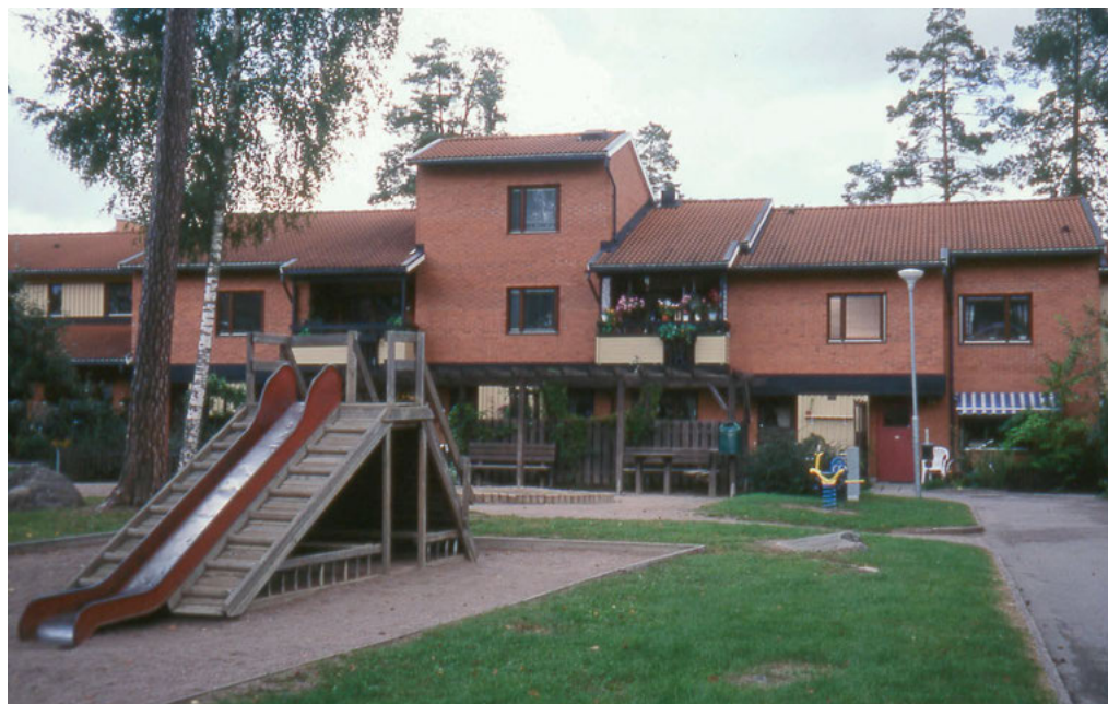
FIGUR 7: I Gottsunda fortsatte byggandet av flerfamiljshus efter miljonprogrammets avslutande 1974. Denna bebyggelse har en annan och mindre skala. Husens utformning är, som detta exempel från kv Dirigenten visar, rikt varierad. Runt den tämligen trånga gården växlar antalet våningar mellan en och tre. De branta takfallen är tillbaka. Varje lägenhet har egen entré, och genom en liten förplats är den privata zonen markerad. Matell arkitekter ab genom Pertti Bengtsson och Robert Martin 1981–1982. FOTO: Emilie Karlsmo 2001.
